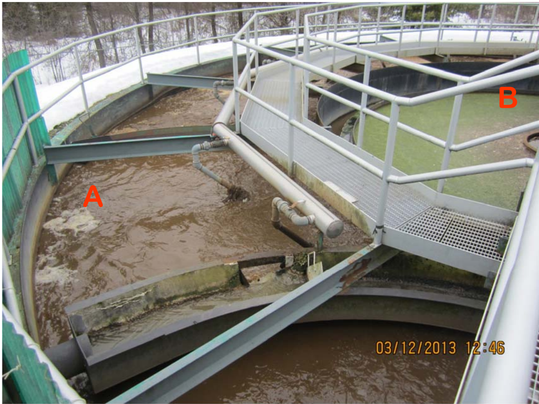
1A) Aeration chamber 1B) Clarifier
